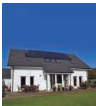
A Panasonic hőszivattyú technológiájával az RHI által kínált lehetőségek maximálisan kihasználhatók. Fife, Skócia. Aquarea
