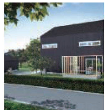
Panasonic hőszivattyúval felszerelt, energiatakarékos új házak. Stavanger, Norvégia. Aquarea
