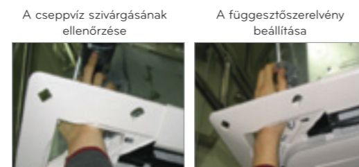
Az előlap sarkai eltávolíthatók / visszahelyezhetők
